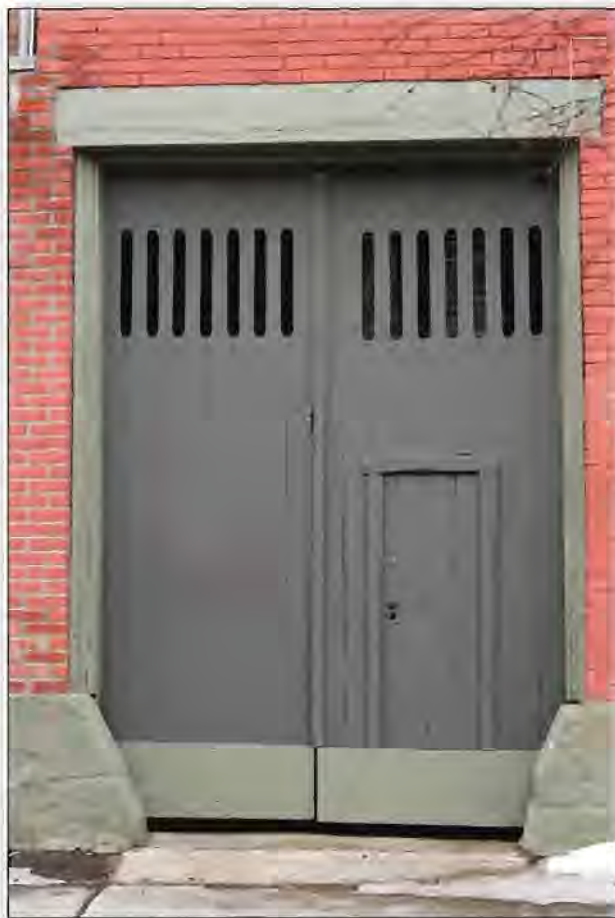
La porte cochère située au 4284, avenue de l'Hôtel-de-Ville, est l'exemple parfait d'une porte ancienne en bois opaque avec la petite porte pour la sortie des piétons. (photo : Gaétan Sauriol)
