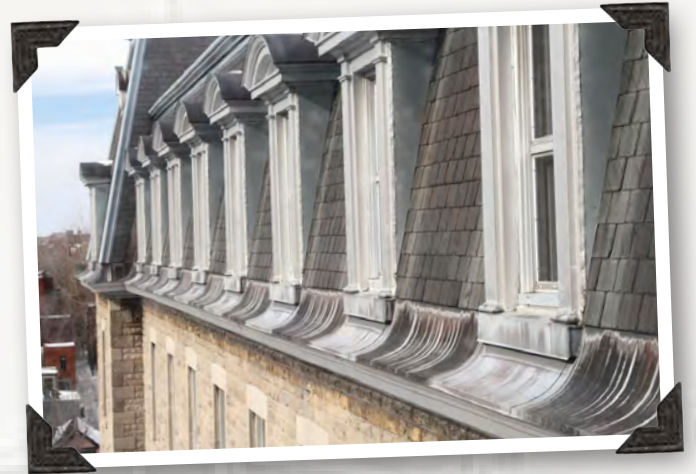
Vue sur les lucarnes de l'ISM Photo : Gaétan Sauriol, 2017
