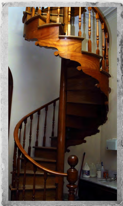
Escalier de bois sculptés en colimaçon derrière la chapelle de l'ISM, 2017 Photo : Gaétan Sauriol
