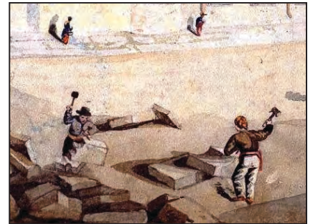
Place d'Armes, 1828 : devant la vieille église de 1683, des artisans, afin de compléter la construction de celle (en arrière-plan) qui va la remplacer, parachèvent les pierres en provenance des carrières du Mile-End 3 .
