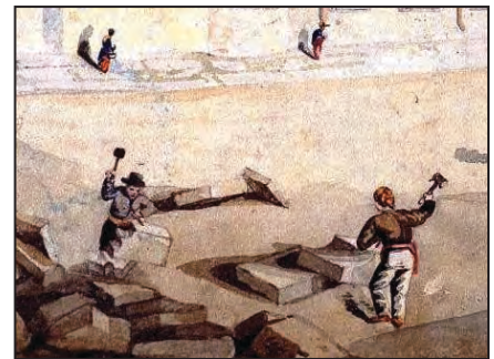
Place d'Armes, 1828 : devant la vieille église de 1683, des artisans, afin de compléter la construction de celle (en arrière-plan) qui va la remplacer, parachèvent les pierres en provenance des carrières du Mile-End 3 .
