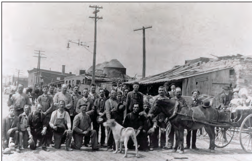
Une autre vue sur les fours à chaux de monsieur Limoges.
