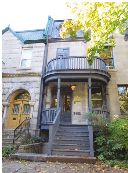
Façade de la maison des écrivains
