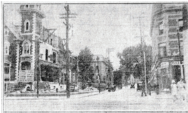
Démolition de la Villa Pia. Source : La Presse , 6 juillet 1928. BAnQ.
