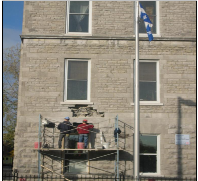
Travaux en cours à la maison de la culture.
