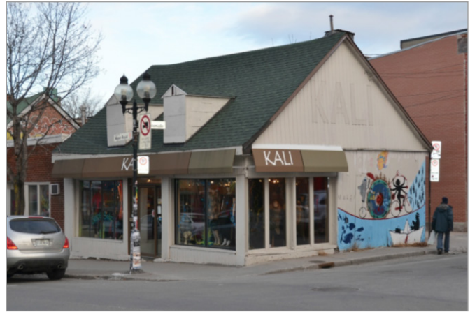
La Maison Kali, avenue Mont-Royal Est Photo Gabriel Deschambault
