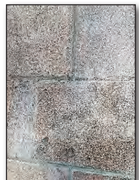
Photo 7: Appareillage de pierres lisses avec pierres bouchardées intercalées.
