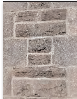
Photo 3: Appareillage sur pan de mur étroit en pierres lisses ornées au centre de moellons équarris.
