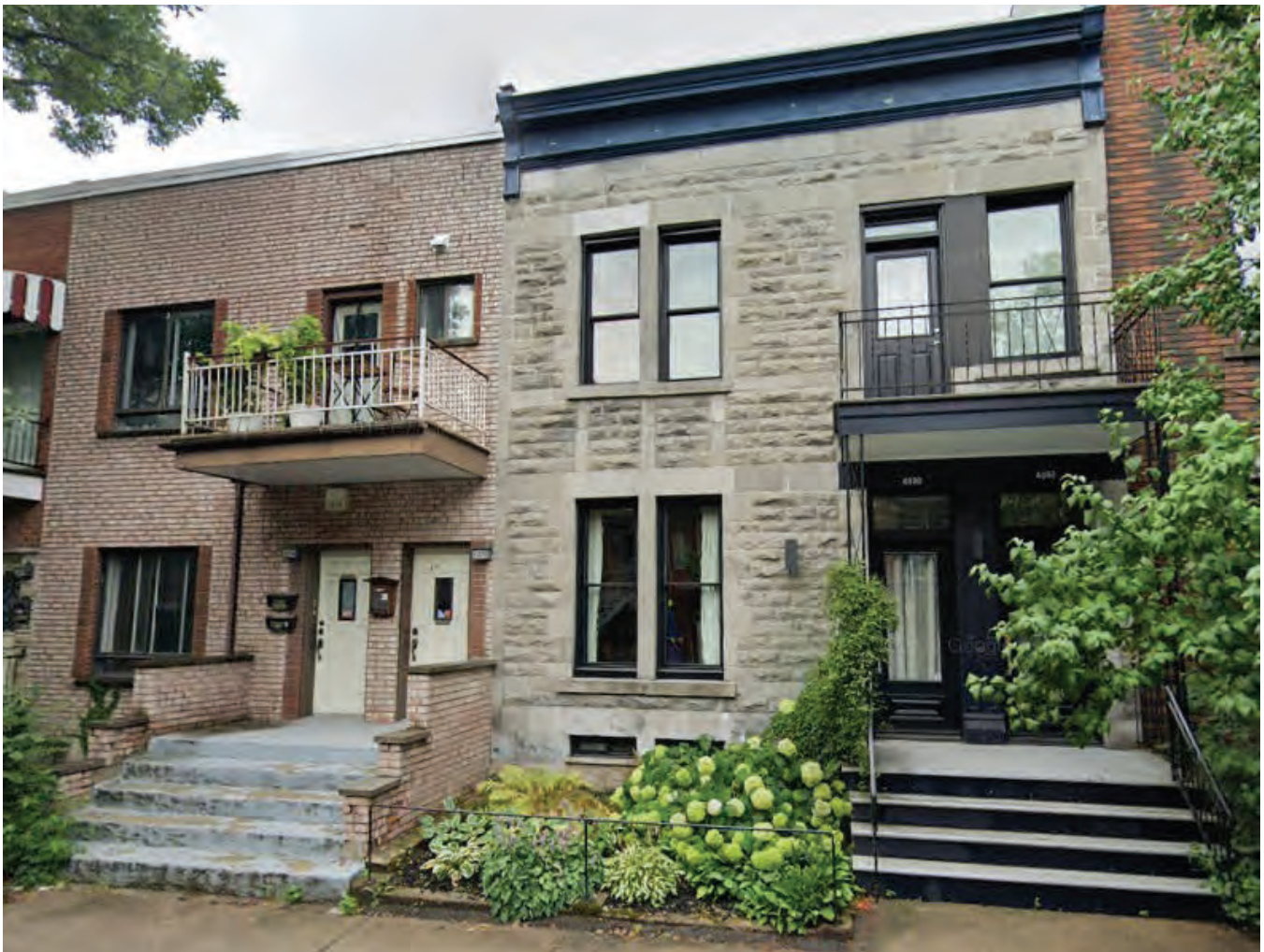
Duplex traditionnel en pierre qui faisait partie d'une série. Son voisin de gauche a été modifié : corniche enlevée, fenêtres diminuées, pierre de Montréal envoyée aux rebuts et brique de mauvaise qualité. Comment une recherche d'économie devient un gaspillage écologique et un appauvrissement collectif et individuel.
