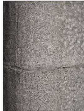
Photo 9: Pierre d'angle arrondie montrant trois traitements différents selon les outils utilisés : ciseau à dent, ciseau lisse et boucharde.
