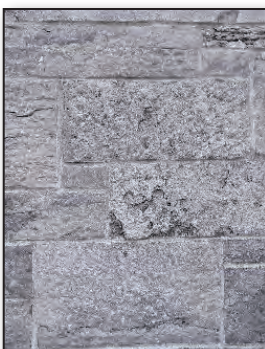
Photo 5: Appareillage de pierres taillées de format et de fini différents. Certaines sont bouchardées.
