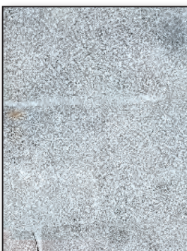
Photo 8: Pierre taillée sur laquelle apparaissent les marques laissées par les outils de taille.
